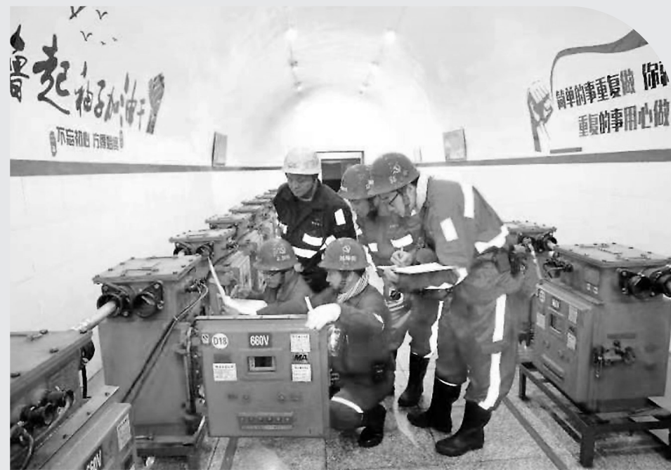
陕煤集团彬长矿业公司小庄矿业公司鼓励员工查找隐患。
